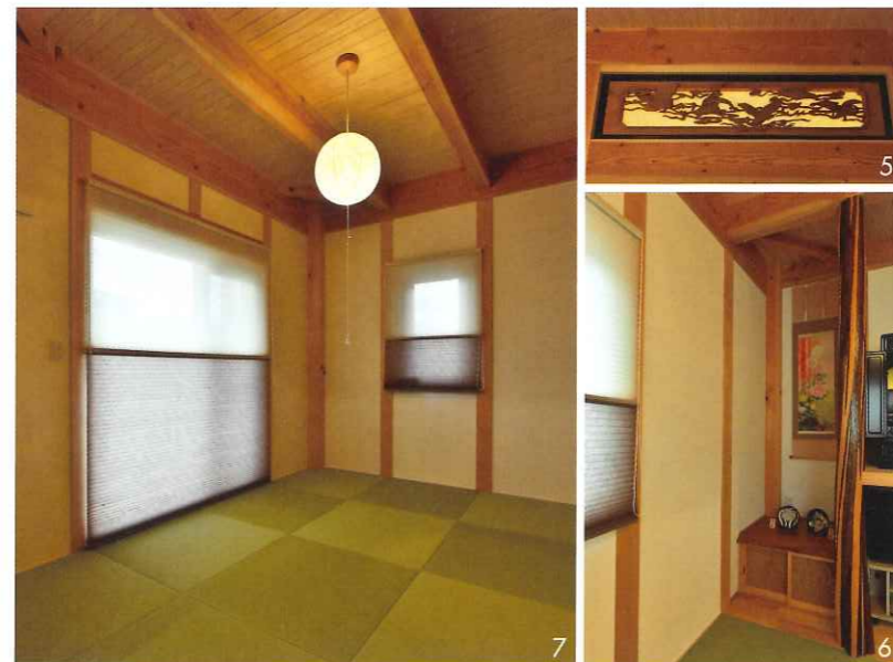
5. 母の部屋に用いた見事な細工の欄間は、大喜工務店が「じっくり馴染む家であらう」と保管していた一点物 6・7. 柱を見せた真壁造りの母の部屋には、古谷さんが選んだ床柱を用いた床の間も
