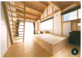
⑤⑥寝室はリビングの延長としても機能することを考慮し、あまり生活感が出ないように意識。ベッドを置かなくてもいいよう、中央に小上がりの畳コーナーを設けている。ロフトへと続く階段部のみメーターモジュールを採用し、少しでも部屋が広く確保できるように工夫した。窓辺に据えたデスクは造作
