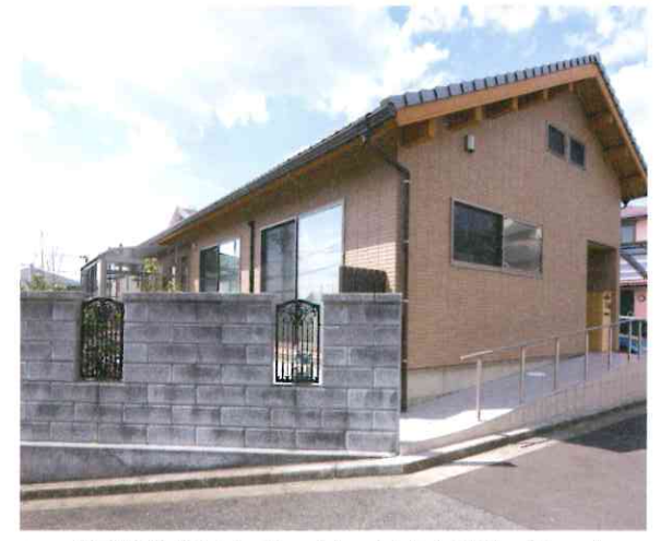
1mの壁面後退を満たしながら、室内のゆとりを重視して建ぺい率いっばいに設計。夏の日差しを遮るため南側の庇を伸ばし、東側の上部に通風の小さな窓を設置。アプローチには階段のほかにスロープも併設した。
