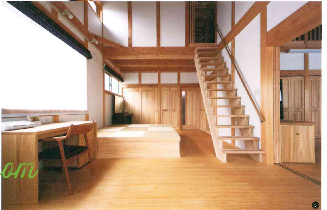
⑤⑥寝室はリビングの延長としても機能することを考慮し、あまり生活感が出ないように意識。ベッドを置かなくてもいいよう、中央に小上がりの畳コーナーを設けている。ロフトへと続く階段部のみメーターモジュールを採用し、少しでも部屋が広く確保できるように工夫した。窓辺に据えたデスクは造作
